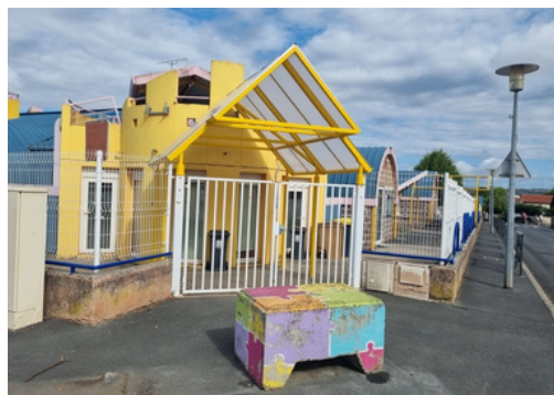
Un auvent a été réalisé au niveau du 2ème portail
